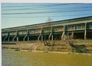
Fabrik für die Kriegswirtschaft. Das seitliche Ausgreifen der Streben wird genutzt, um die Geleise zur Anlieferung des Eisens der Halle entlang zu führen.
